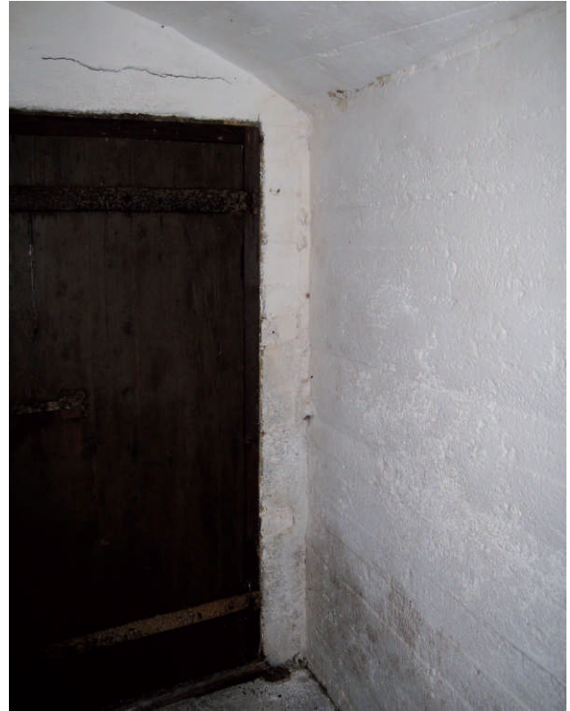
Kellarin eteisen seinä on pysynyt vaaleampana. Kuvan sisäovi on alkuperäinen.
