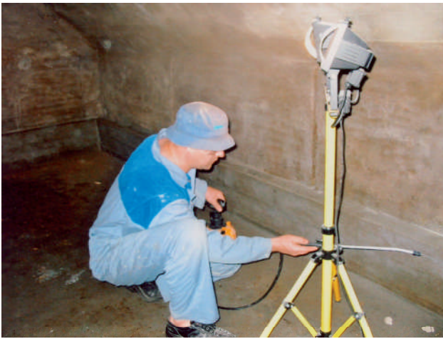
Kalkkiveden levitys tehtiin pienellä paineruiskulla. Sen avulla levitys kävi vaivattomasti. Kalkkiveden pintaan muodostunut riite on poistettava, jotta ruiskun suutin ei tukkeudu.
