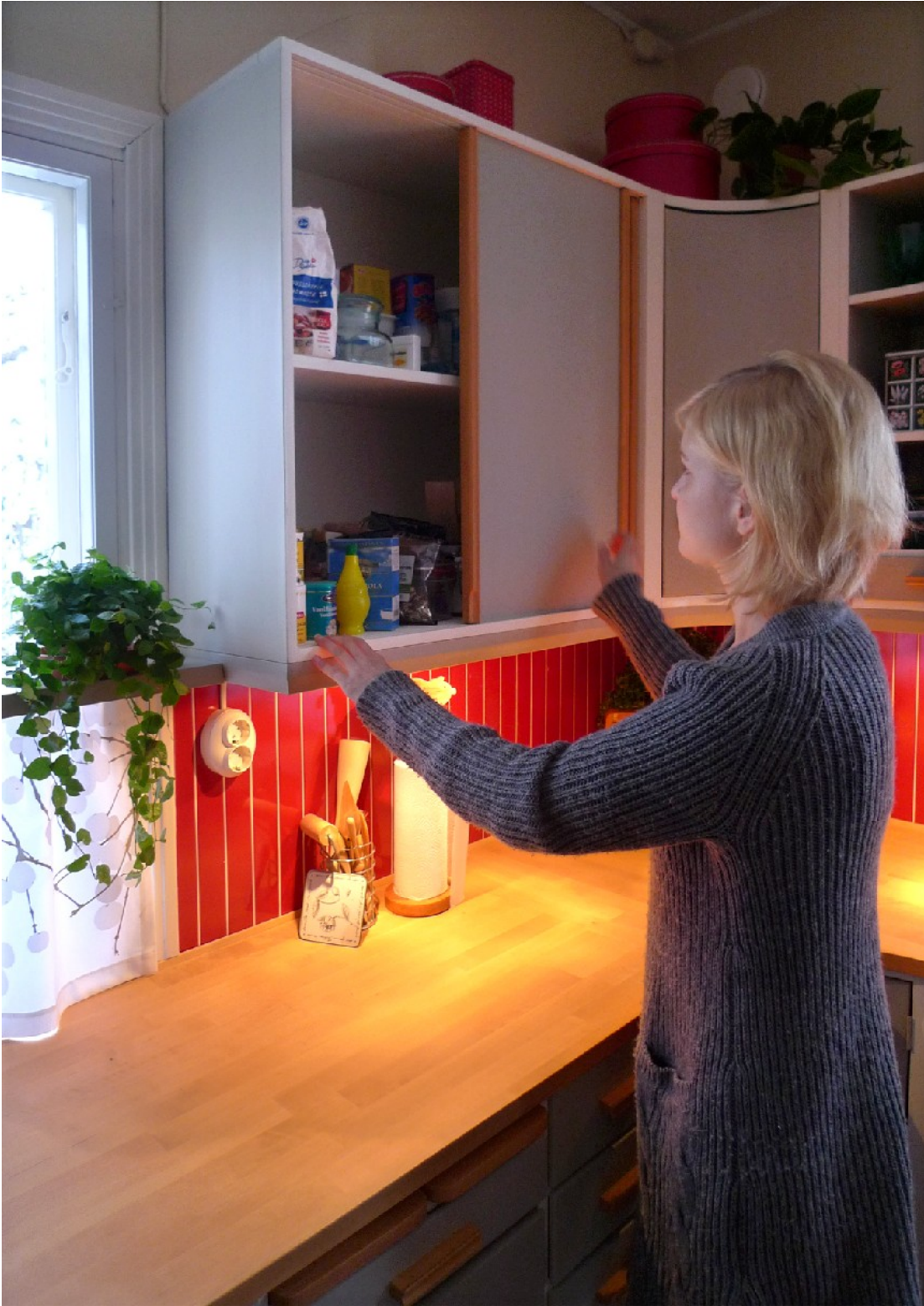
Yläkaappien liukuovien hahlot käsiteltiin steariinilla ovien liikkumisen parantamiseksi.
