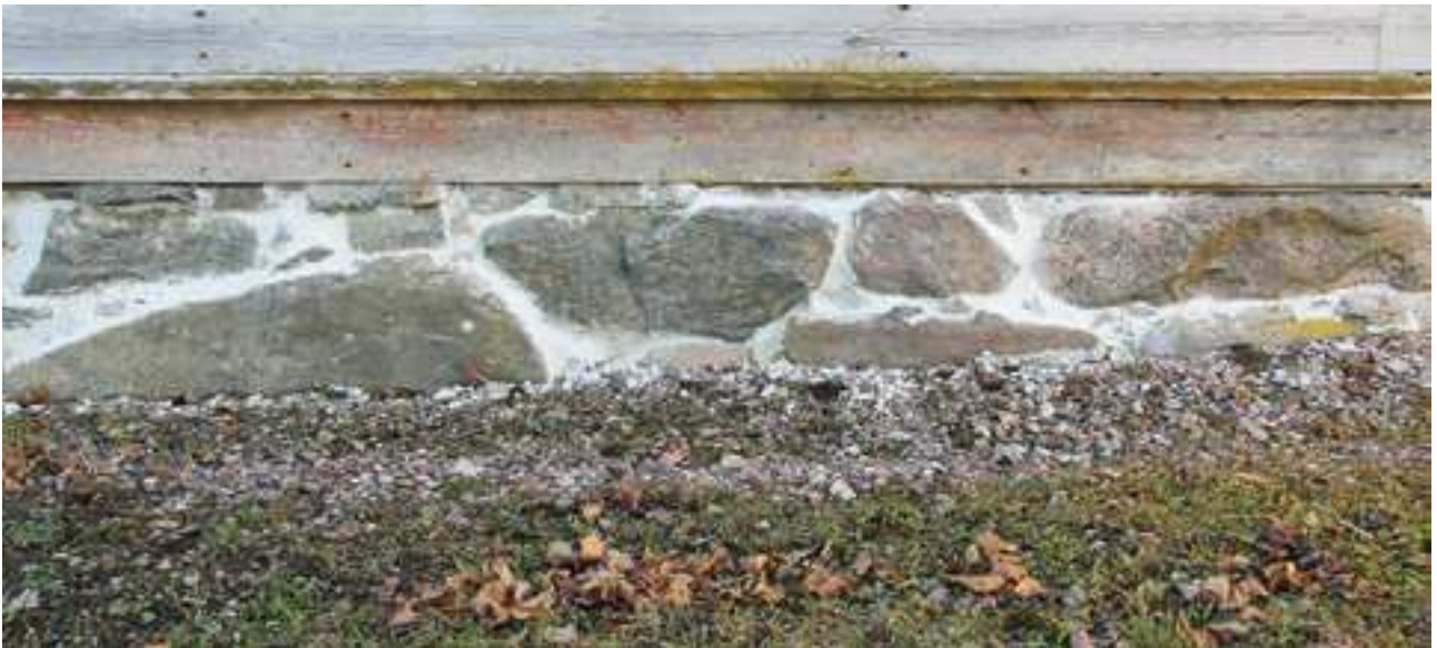
Valmiiksi saumattua kivijalkaa. Saumaus on kuivunut jo muutaman kuukauden ajan. Kuva: Ville-Matti Rautjoki, muut kuvat: Tuovi Rautjoki.
