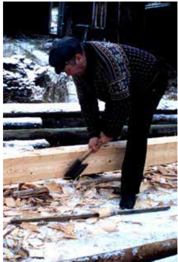
Mestari kirvesmies Verner Rintamäki veistää aitan alle tulevaa hirttä Kauhajoella umpipihaisen Hämes-Havusen talon työmaalla 1977. Verner palkittiin opetusministeriön aloitteesta ansioistaan katoamisillaan olleen kirvesmiesperinteen välittämisessä tuleville sukupolville Suomessa.
