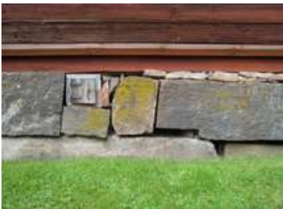
Perinteisessä hirsitalossa julkisivu on yleensä kauniisti samassa linjassa kuin sokkeli. Yli-Laurosela, Ilmajoki.
