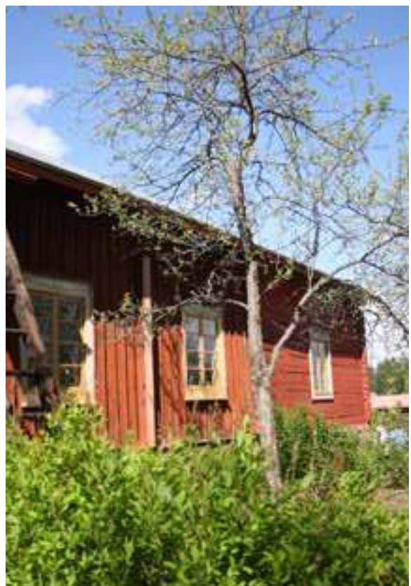
Lohjansaaren Pietilässä ei ole käytetty muovia eikä betonia, ei myöskään lasi- tai kivikuituisia eristeitä. Luettelo talon rakennusmateriaaleista – vanhoista ja uusista – on lyhyt: puu eri tavoin työstettynä, tuohi, poltettu savitiili, savilaasti, ikkunalasi, rautanaulat ja kattopelti. Eristeinä on mm. pellavaa, purua, hiekkaa ja sammalta, korjatuissa rakenteissa nykyajalle myönnytyksenä myös puukuitueristettä. Kuva: Viri Teppo-Pärnä.
